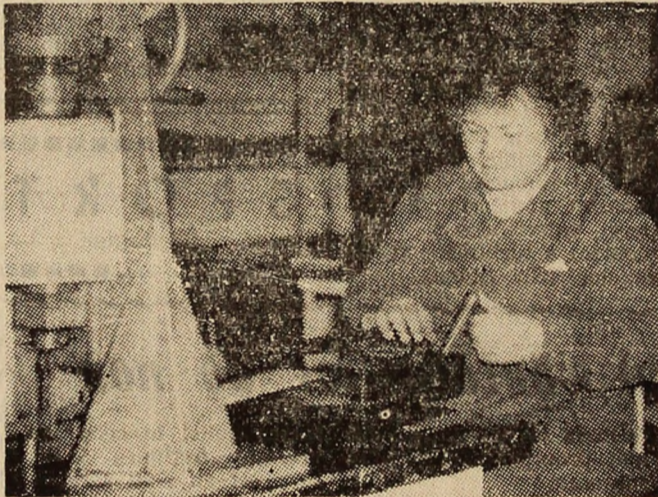
Laboranta Ana Toacă lucrează la încercarea rezistenței firelor de la cablul instalației de extracție în cadrul laboratorului IPSRUEEM Petroșani. Foto: R. TAVIAN
