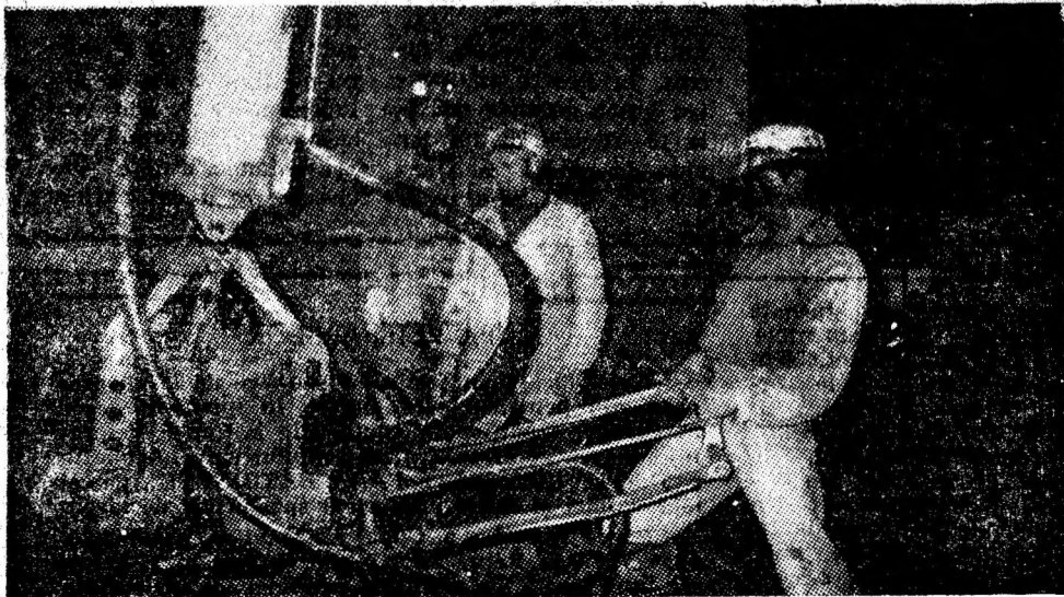
Sub atenta conducere a șefului de schimb Virgil Beștea, greiferul mușcă din vatra noului puț aflat în lucru la I.M. Paroșeni.
