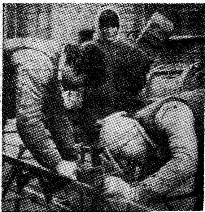
La IM. Paroșeni, se recondiționează suporturi pentru benzile transportoare.
