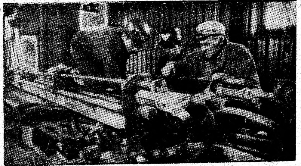
Maistrul Iosif Șincai împreună cu ortacii de la IM Iseroni execută ultimele verificări ale instalației de perforat găuri de mină la puțurile de săpare. Foto: George COLȚIȘOR
