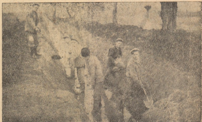
ÎN CLIȘEU: Executarea canalului principal pe pășunea „Rituri” din comuna Galda de Jos.
