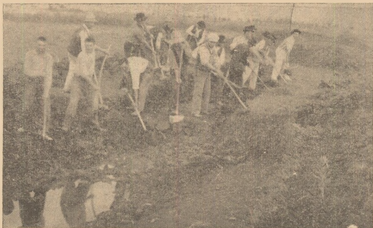
Un grup de țărani întovărășiți din comuna Cricău la săpatul canalului pentru îndreptarea cursului văii Craivii.
