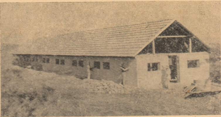
La G.A.C. Bucurdea Vinosă se începe de zor la terminarea construcțiilor. În clișeu: Executarea lucrărilor de tencuire la malernitatea de scroafe.
