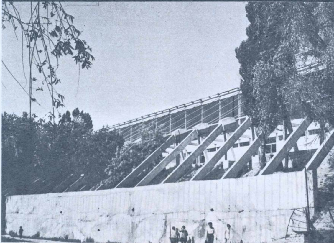
Patinoarul 23 August. Fundațiile de ancoraj pentru cablurile laterale, la exterior.
