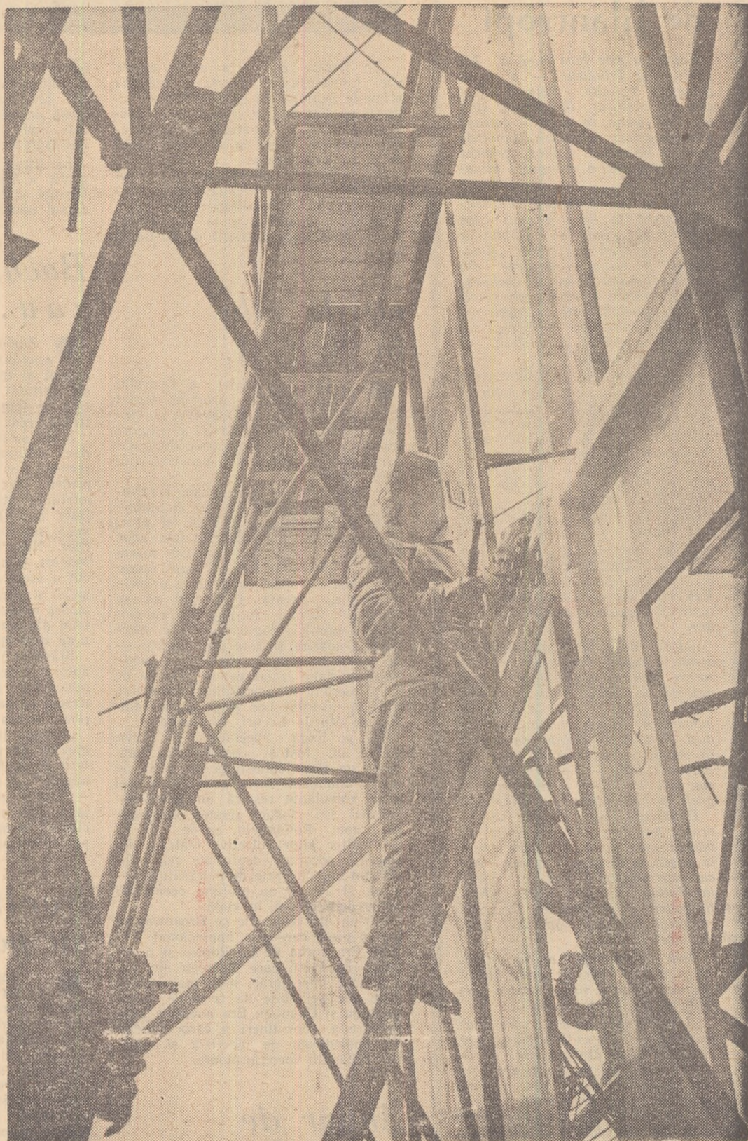
Pe șantierele noilor case ale septenalului, metode moderne de construcție...
