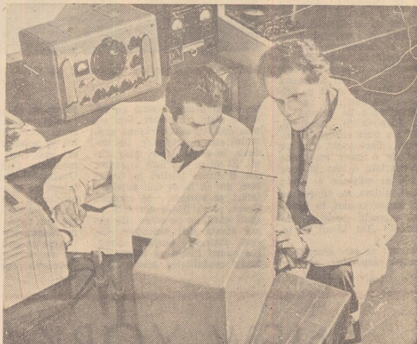
Acest aparat nou, numit magnetoscop, este folosit la determinarea calității oțelului și controlul calității prelucrării termice a pieselor. Este portativ, nu cântărește mai mult de zece kilograme și efectuează controlul prelucrării termice a pieselor în numai 5-7 secunde.
