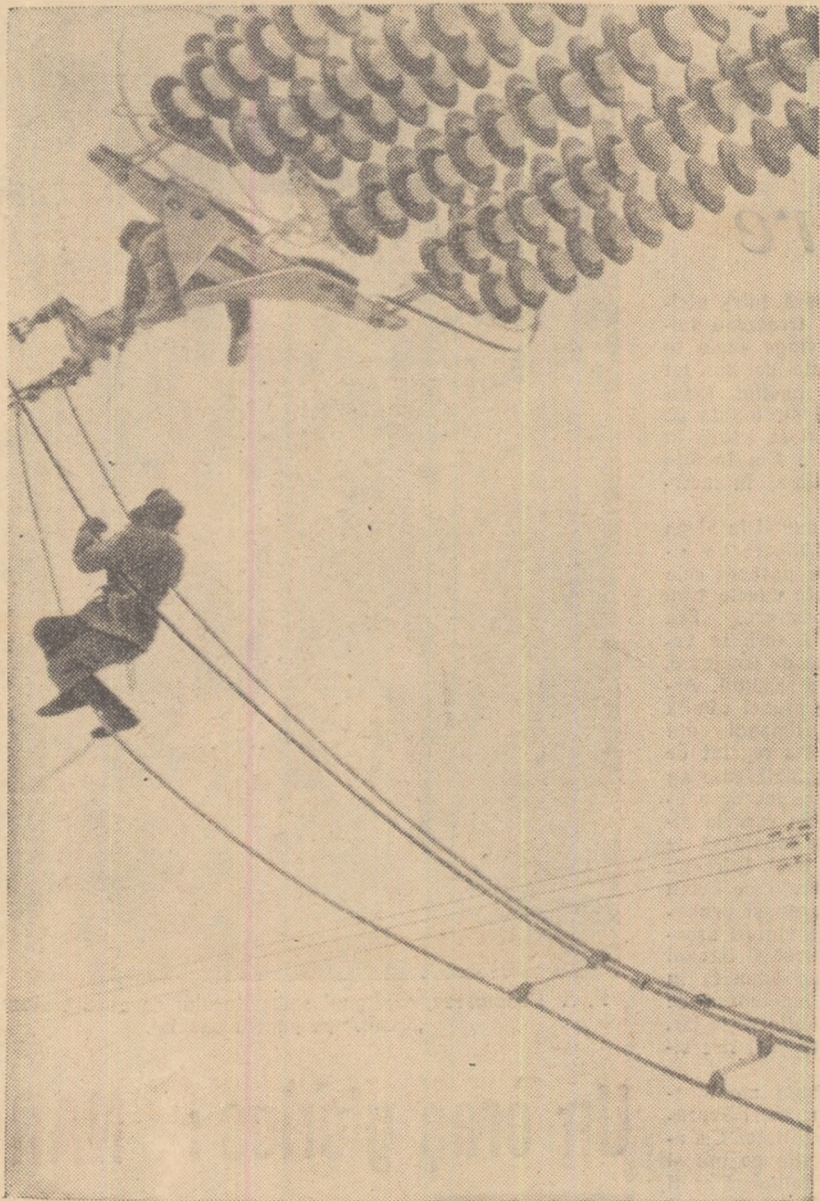
Se montează o linie de înaltă tensiune
