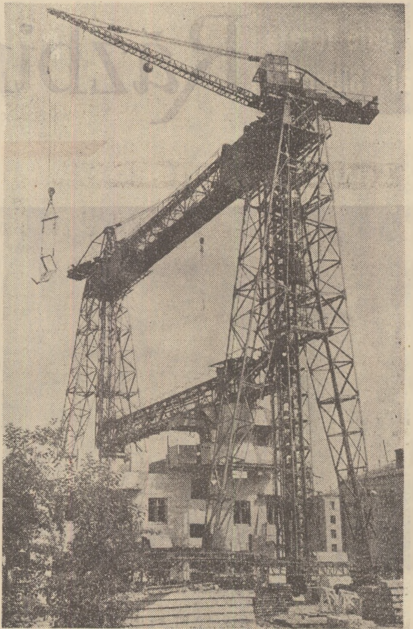
Mașina de construit case, realizată de doi ingineri sovietici, este un nou pas spre mecanizarea complexă a proceselor de construcție. Mașina e deservită de numai cinci oameni.
