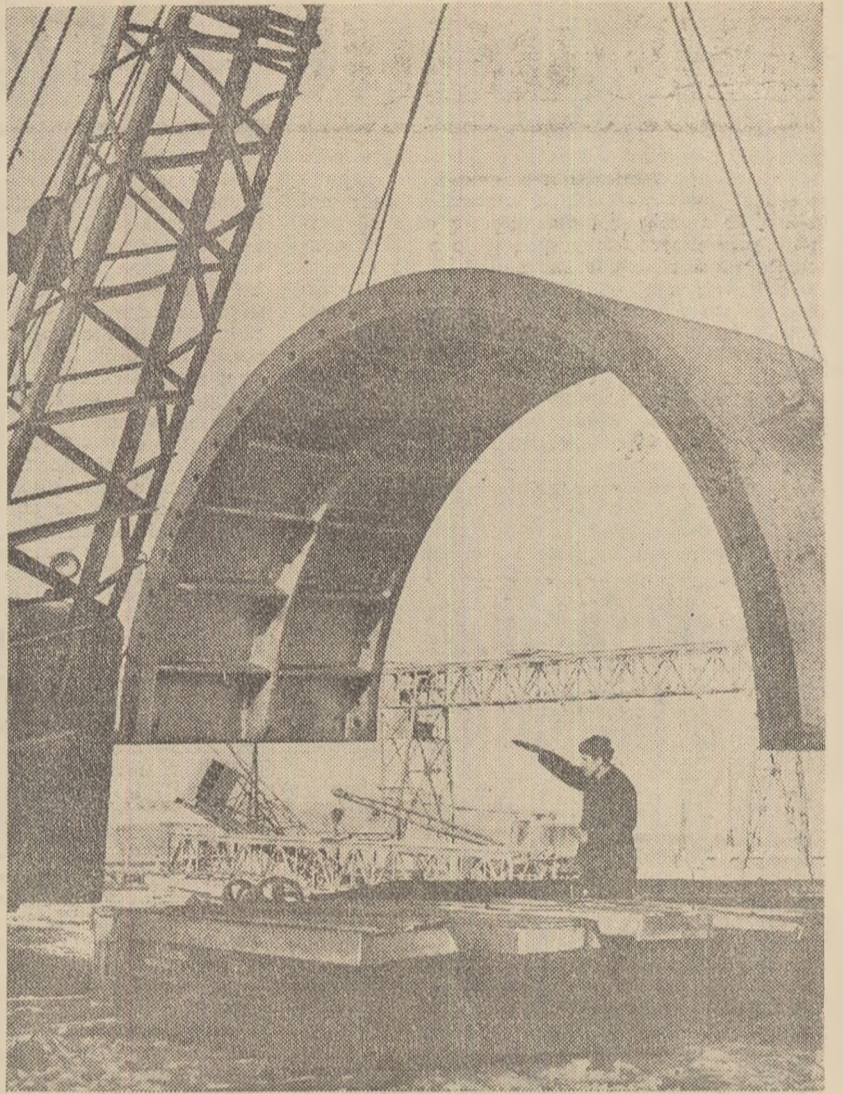
Turbine pentru termocentrala de la Cerepet.
