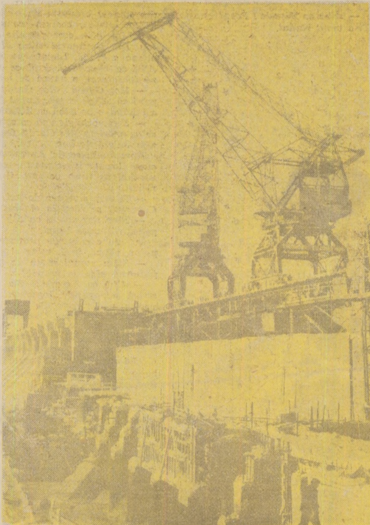
O nouă hidrocentrală în construcție.
