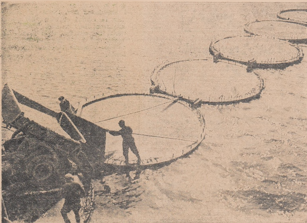
Deși foarte asemănătoare la prima vedere cu gigantica Victoria regia, „frunzele“ din fotografie nu sînt nici flexibile, nici mișcătoare. Construite din metal, inelele au fost transportate cu ajutorul unei macarale plutitoare în largul mării. Aici au fost umplute cu nisip și legate între ele cu punți de beton. Pe suprafața lor se amenajează acum o dană care va deservi portul pescăresc Klaipeda (R.S.S. Lituaniană).
