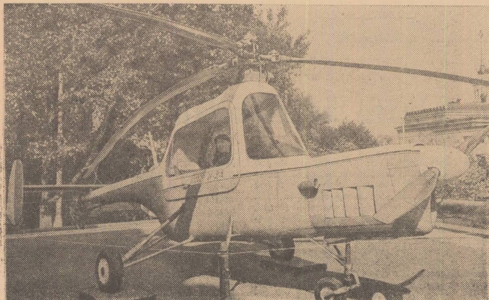
O nouă creație a studenților de la Institutul de aviație din Harkov: autogirul, prevăzut pentru deplasări pe distanțe mici.
