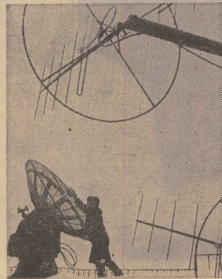
Stația siberiană „Meteorit” pentru urmărirea automată a radiosondelor, una din verigile pe baza cărora se alcătuieste prognoza timpului
