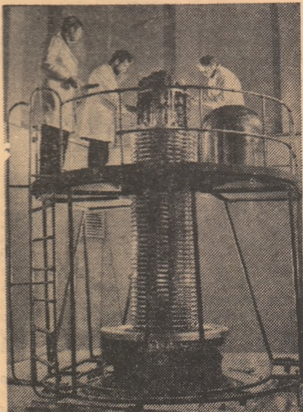
Echipamentul electric — un act indispensabil al vieții moderne
