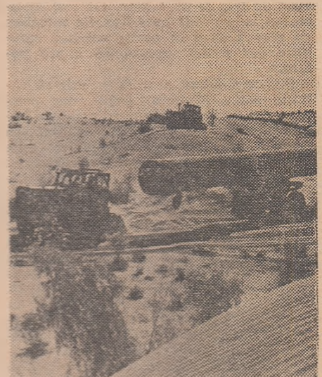
Pe șantierul conductei Șatlink-Hiva (Asia Centrală)
