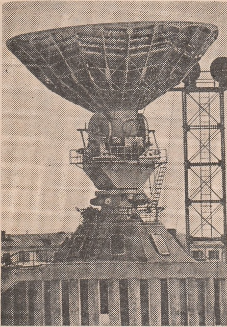
Stație de tip „Orbita” pentru retransmiterea — prin sateliți artificiali — a emisiunilor postului de televiziune Moscova în cele mai depărtate colțuri ale U.R.S.S.
